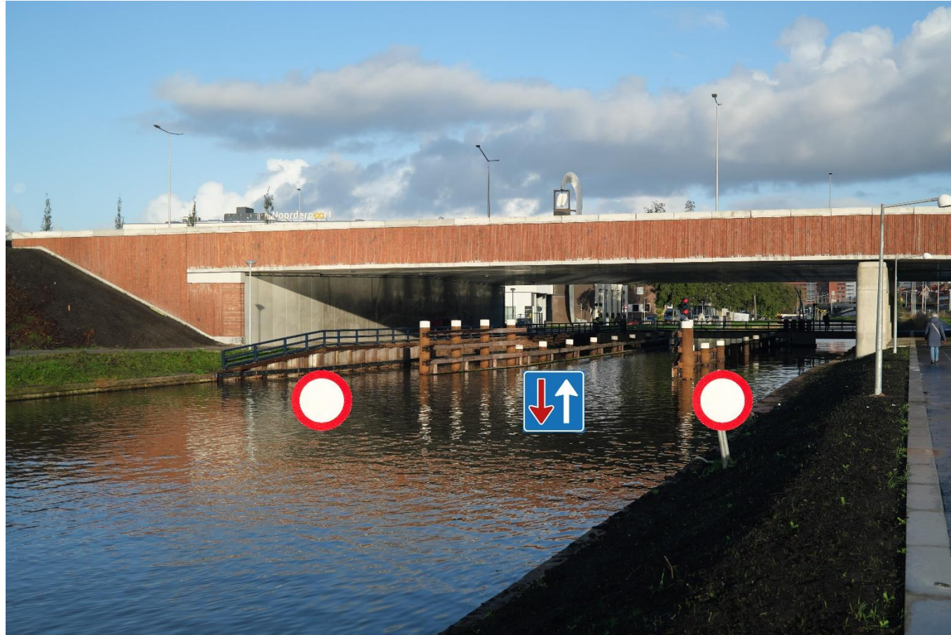
Afbeelding 18 Julianabrug, met daarachter de Muntingbrug (zie afbeelding 19 voor de Muntingbrug); linkerbruggat: niet doorvaren, ongeacht de vaarrichting. Middelste bruggat: roeiers die “stad in” varen hebben het recht van voorrang. Rechterbruggat: niet doorvaren, ongeacht de vaarrichting.
