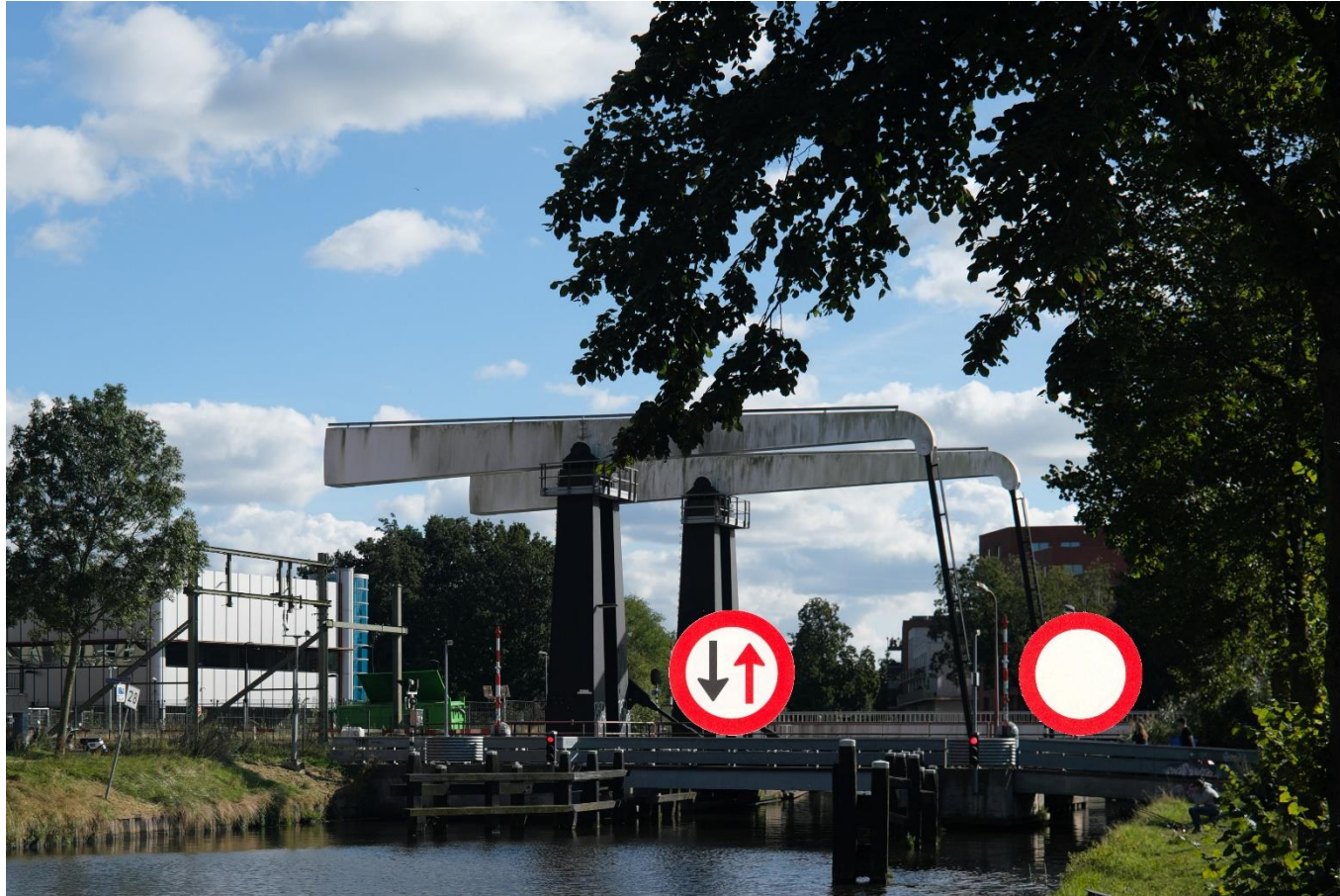
Afbeelding 8 Van Hallbrug (met daarachter de Spoorbrug Groningen en de Zaanbrug, zie afbeelding 9 voor een bovenaanzicht); linkerbruggat: verleen voorrang aan roeiers die naderen op een tegengestelde koers. Rechterbruggat: niet doorvaren, ongeacht de richting.
