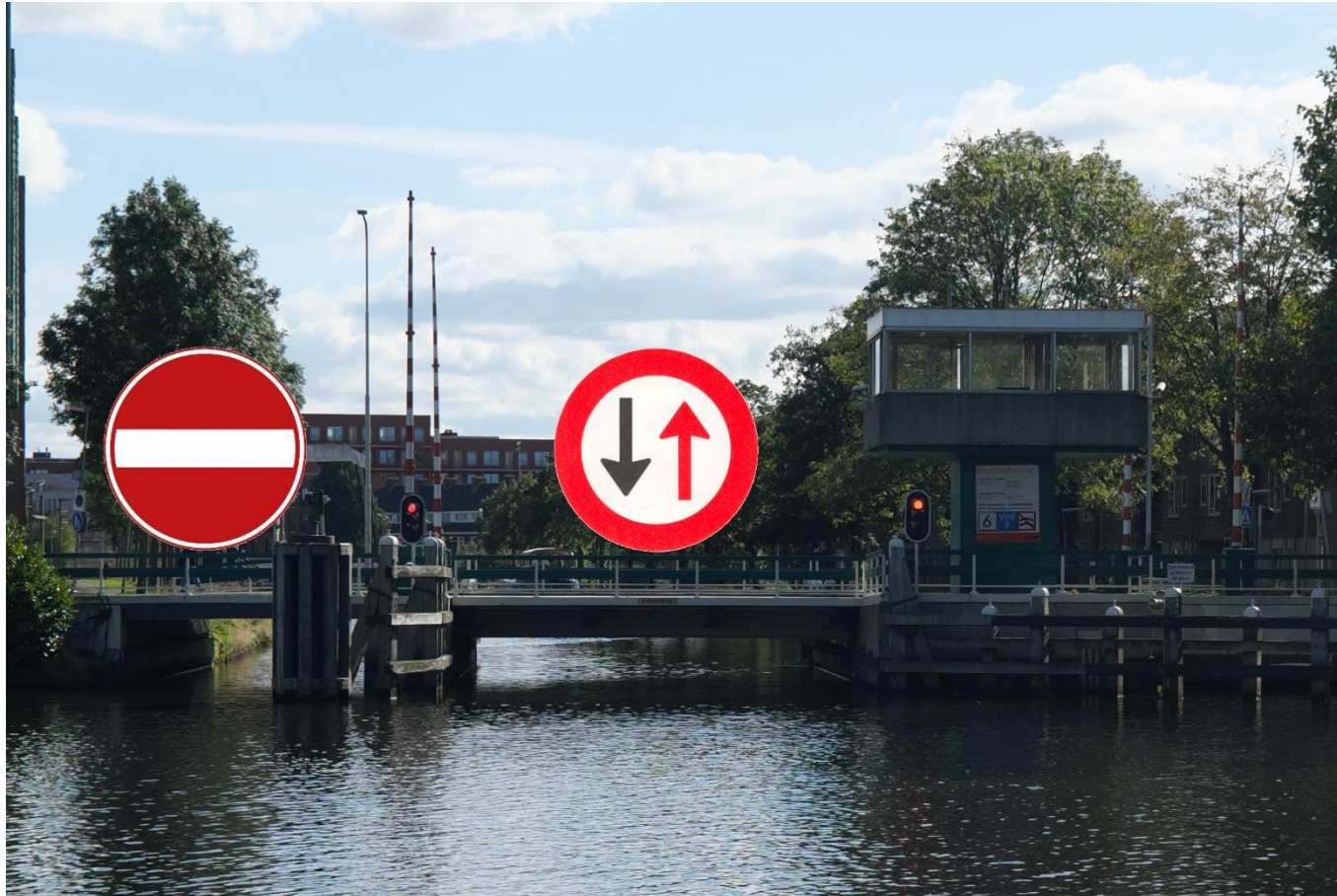
Afbeelding 7 Eelderbrug; linkerbruggat: niet doorvaren in de richting “stad uit”. Rechterbruggat: verleen voorrang aan roeiers die naderen op een tegengestelde koers.
