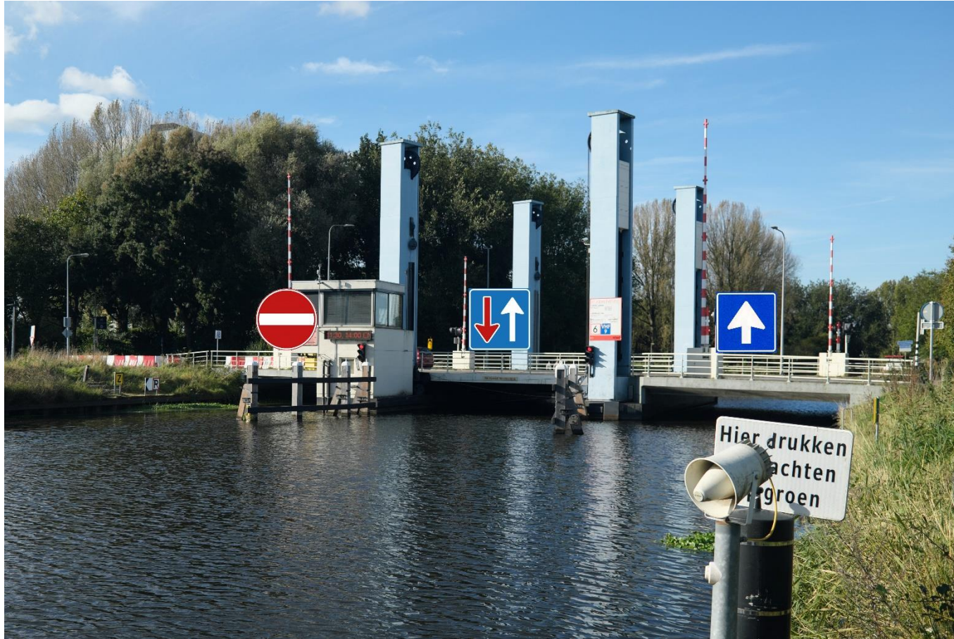
Afbeelding 16 Van Ketwich Verschuibrug; linkerbruggat: niet doorvaren in de richting "stad in". Middelste bruggat: roeiers die "stad in" varen hebben het recht van voorrang. Rechterbruggat: uitsluitend doorvaren in de richting aangegeven door de pijl, dit bruggat is smaller.
