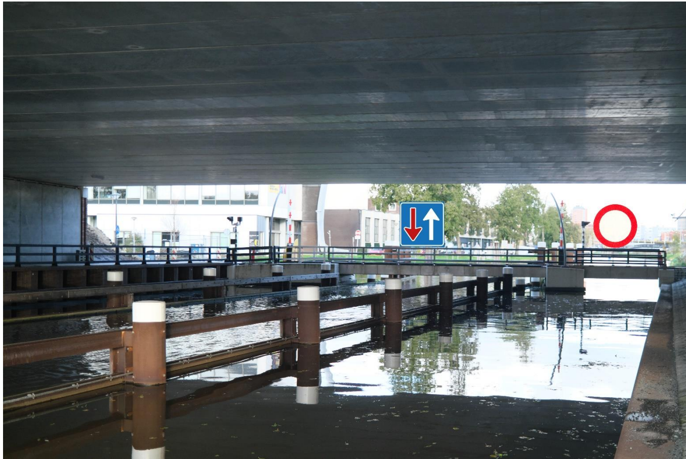
Afbeelding 19 Muntingbrug; linkerbruggat: roeiers die “stad in” varen hebben het recht van voorrang. Rechterbruggat: niet doorvaren, ongeacht de vaarrichting.
